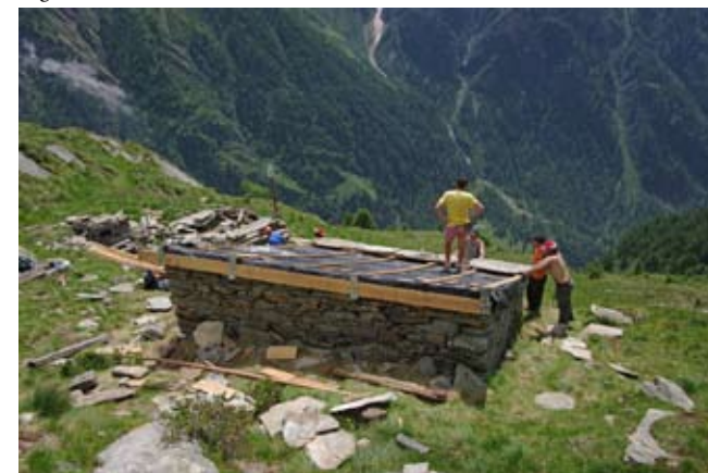
luglio 2008 - la posa del tetto.
