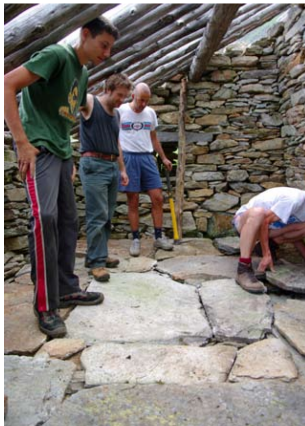
luglio 2008 - la posa del pavimento.
