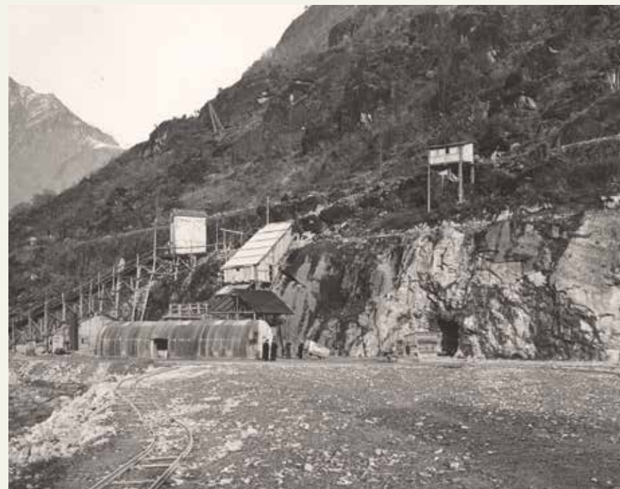
Anni '50. I lavori di scavo della galleria per servire la centrale di Prata (archivio Edipower - Mese).
